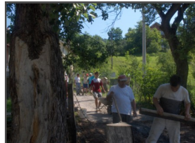
Sanacija puta i zaštita od erozije, Solina
