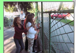
Popravak ograde prema ulici, OŠ Jala
