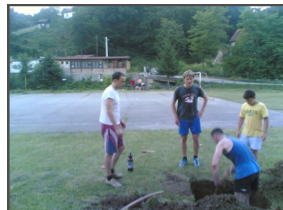
Pripreme za postavljanje rasvjete, Lipnica
