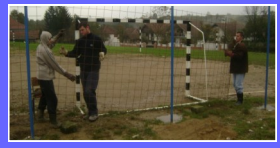
Postavljanje zaštitne mreže - okt 2010.
