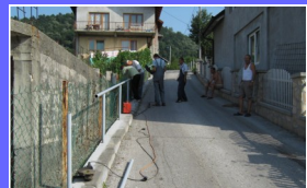
Akcija izgradnje rukohvata - sep 2010.
